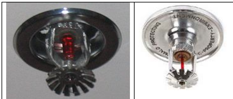
Figura 13: Pulverizadores de incendios
