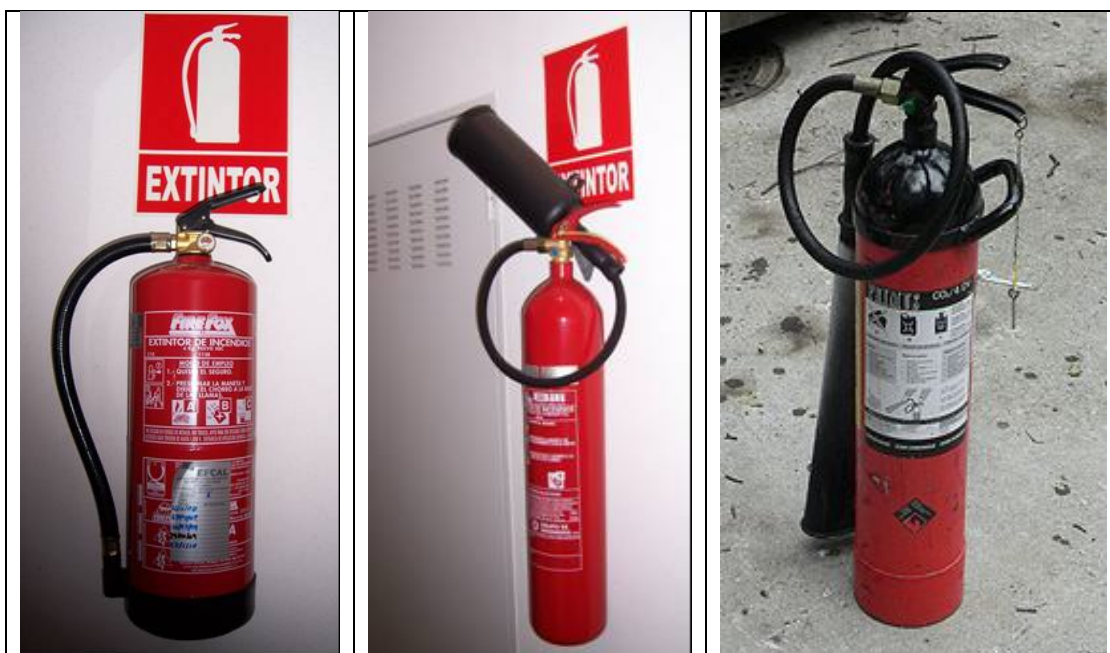
Figura 8: Diferentes tipos de extintores de incendios portátiles
