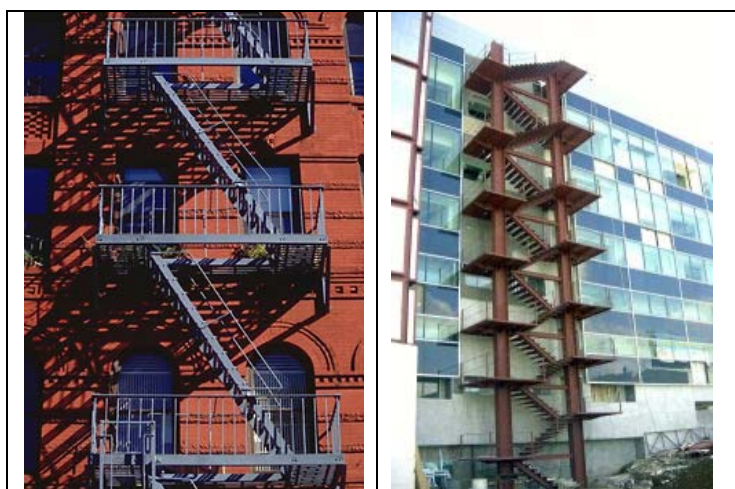
Figura 15: Escaleiras exteriores de incendios
